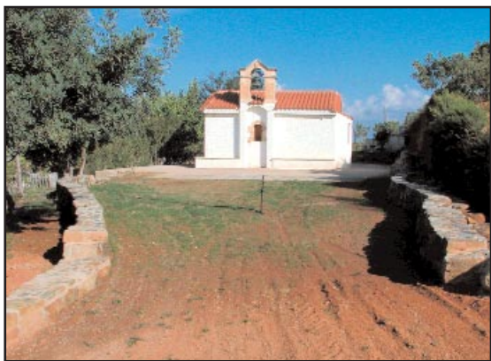
Οι σπουδαστές ολοκλήρωσαν το χτίσιμο των καθισμάτων στο ναό της Μεταμορφώσεως του Χριστού.
